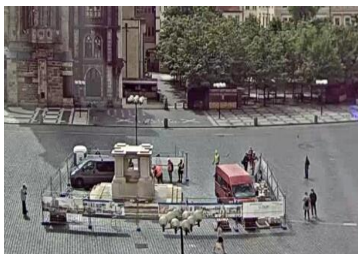
Druhá etapa obnovy sloupu – stav k 5.5.2020
