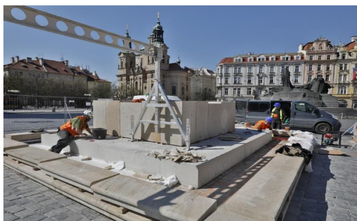
První etapa obnovy sloupu – stav v květnu 2020
